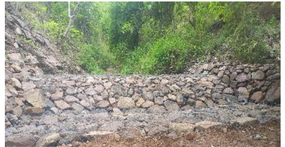
రాతి కట్టల డ్యామ్ నిర్మాణం
