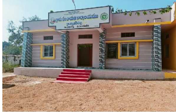
గ్రామ పంచాయతీ భవనం - క్యాతన్ పల్లి గ్రామపంచాయతీ, దామరగిద్ద మండలం, నారాయణపేట
